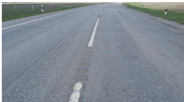
Рис. 4. Использование шумовой полосы совместно с ГДР (фото Скрылёва Г.В.)
