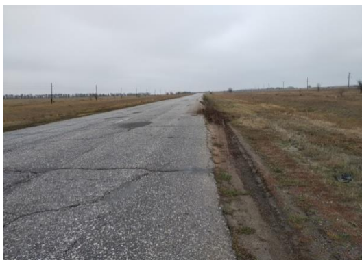
Рис.3. Прямолинейный участок автомобильной дороги с неукреплённой обочиной (фото Скрылёва Г.В.)
