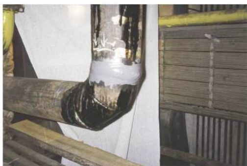
Заделка течи трубопровода.
