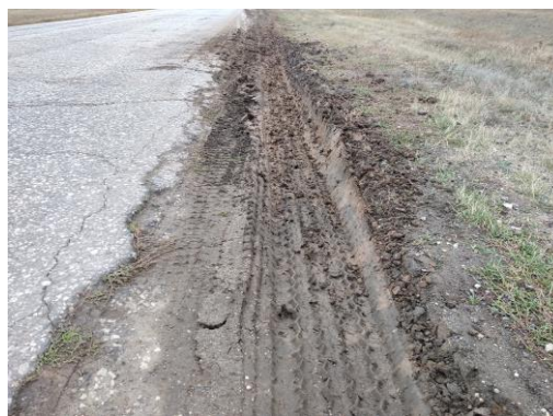
Рис.3. Прямолинейный участок автомобильной дороги с неукреплённой обочиной (фото Скрылёва Г.В.)
